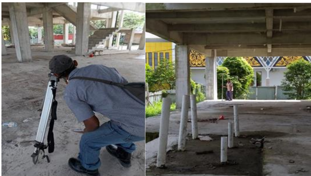
Gambar 6. Pengukuran Beda Tinggi dengan Waterpass
