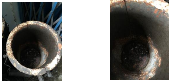
Gambar 5. Kondisi Karat Pada Cetakan Beton dengan Komposisi Cocopeat 50% (Riset, 2021)
